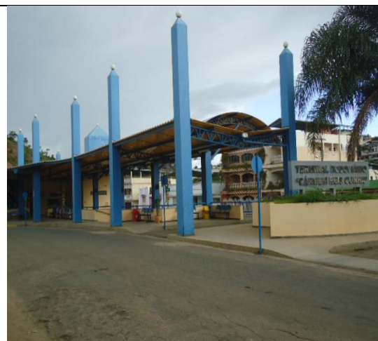
Figura 10: Terminal rodoviário de Coimbra.
